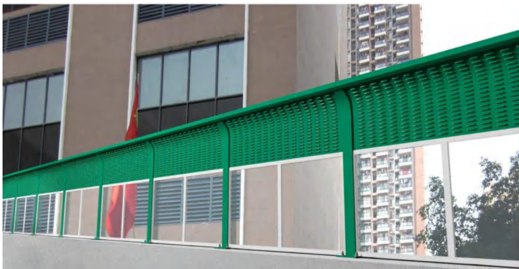
图 6-2 直立式声屏障工程实例图
