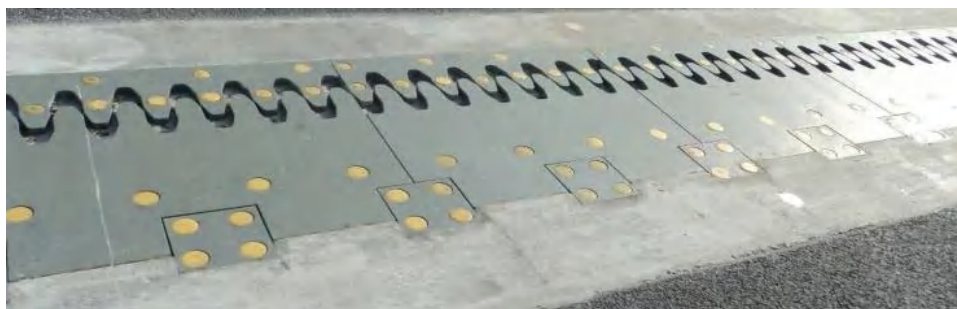
图 6-1 降噪型伸缩装置工程实例图
